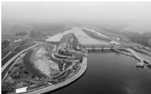
Rys. 4. Stopień wodny Malczyce – stopień rozbudowy 2019 r. [13]
