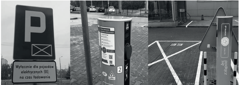
Rys. 1. Stacja ładowania pojazdów elektrycznych w Tychach
